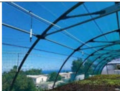
Ancien système d'irrigation avec 5 rampes d'arrosage et les asperseurs espacés de plus de 2 mètres
